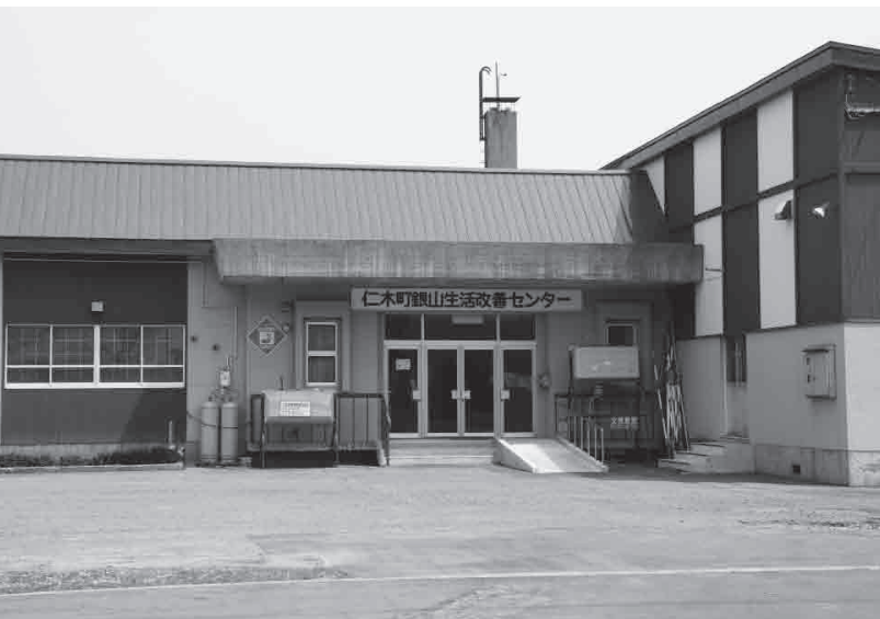
建築から40年を経過した銀山生活改善センター（銀山地区）
