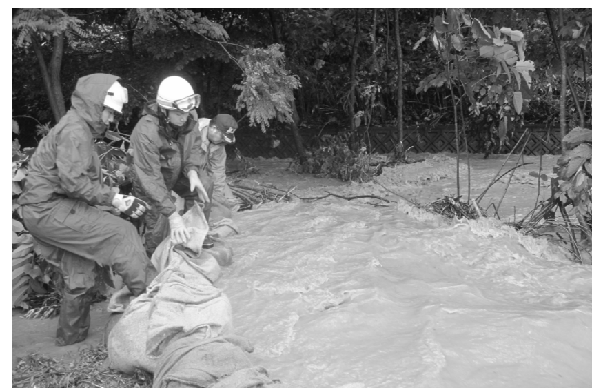
氾濫した河川の土のう積み (平成22年7月豪雨災害)
