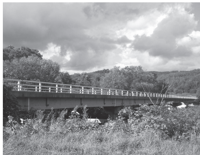
漁別橋の補修工事を一部前倒しで実施します
