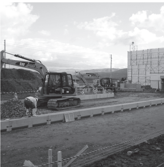
ぎんれい36内の道路・駐車場整備
