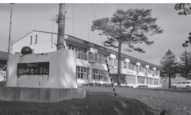
鷹栖中央小の廃校舎を利用しているデイセンター
