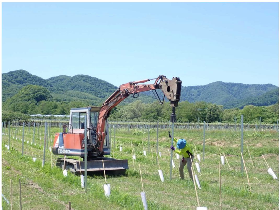
5-2：垣根の構築作業（中柱の設置）
