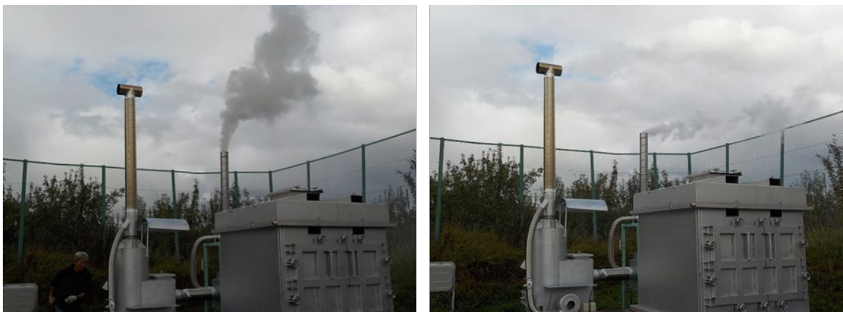
図 3-3 二次燃焼器を使用した場合の様子
