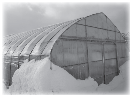
資材の高騰が続いています
