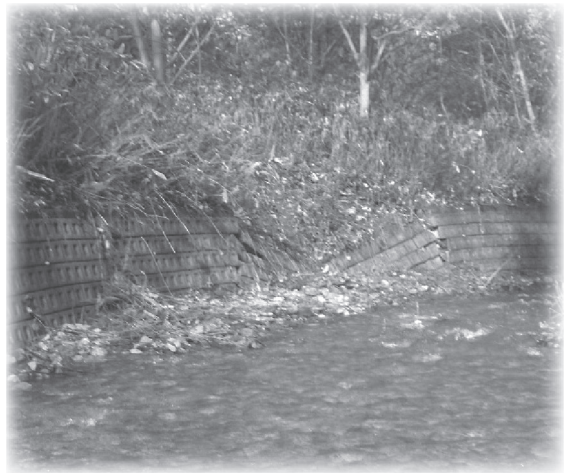
施工業者の不足は大きな影響を及ぼします
