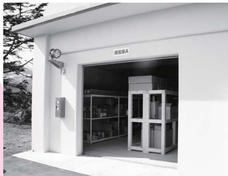
役場横の備蓄庫。有事の際に使用する機材や食料を備蓄しています。
