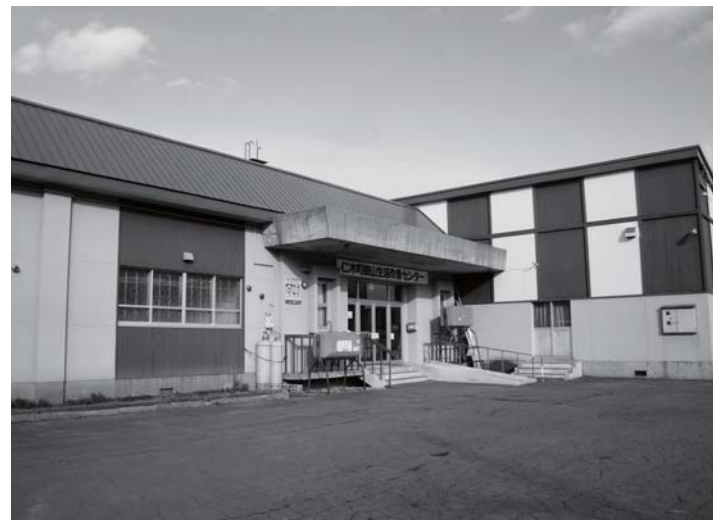
昭和45年建設(築47年)の銀山生活改善センター
