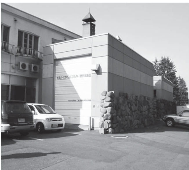
木質バイオマスエネルギー熱供給施設（北海道下川町）
