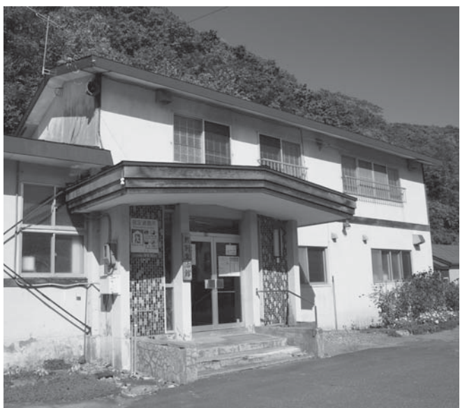
改修が望まれる然別生活館
