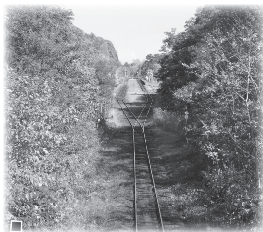
然別駅は2面2線構造となっています
