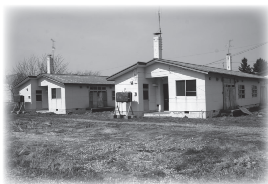
老朽化により取り壊す予定です
