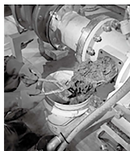
(ポンプに詰まった異物の除去作業)
